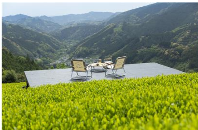
藤枝市一ノ瀬 ティーテラスの設置
